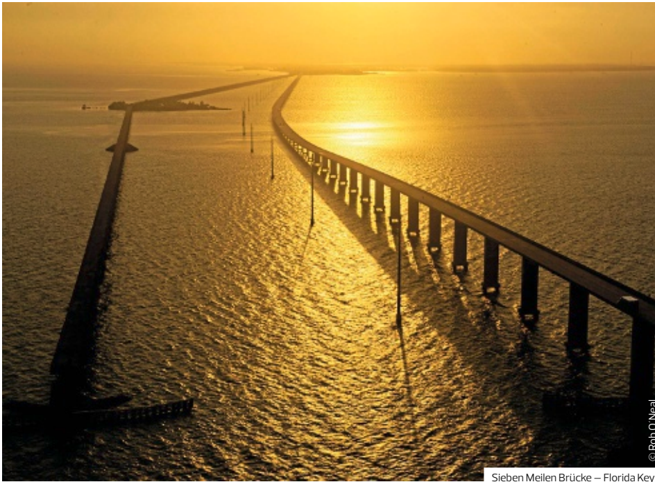
Sieben Meilen Brücke – Florida Keys
